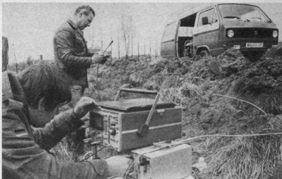
Verlegung von Glasfaserkabeln: "massenweise Arbeitsplatzvernichtung"
