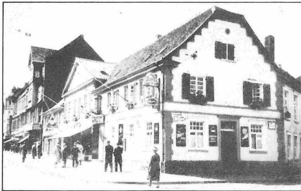
„Hotel zur Post“ in Opladen (inzwischen abgerissen)
