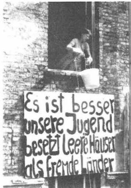
Alternative Sanierung: "Versuch, die Bausubstanz zu retten"
